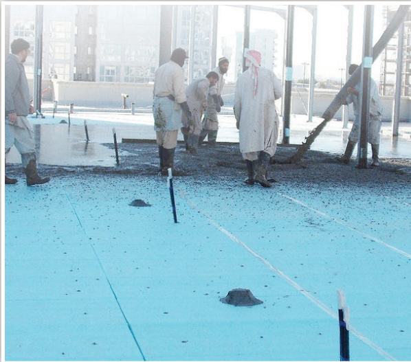
( الشكل - 5 ) ألواح العازل الحراري ويلاحظ الشريط الاصق
